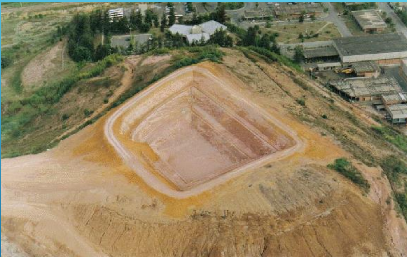
barragem para rejeitos. Fonte: http://www.lapes.ufrgs.br
